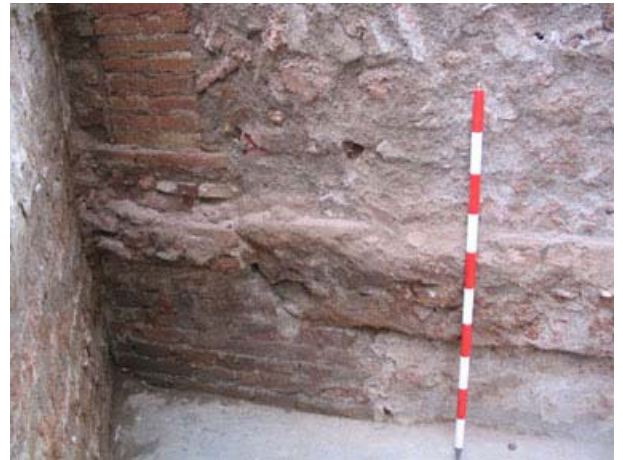
FOTO 18. Vista en detall de l'ampliació de la fonamentació del pilar UE 70 així com de l'afegit de morter UE 69
