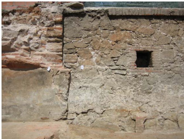
FOTO 19. Vista en alçat de la relació entre els murs UE 77 i UE 13, així com la canalització de desguàs UE 84
