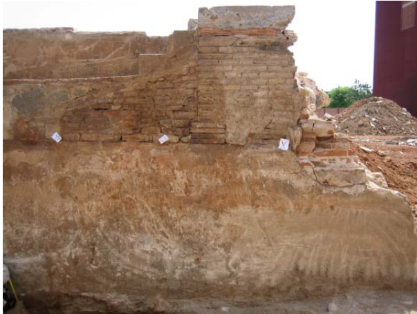
FOTO 13. Vista en alçat de les escales UE 19, de les estructures UU EE 20 i 79, i de part del mur de contenció UE 11
