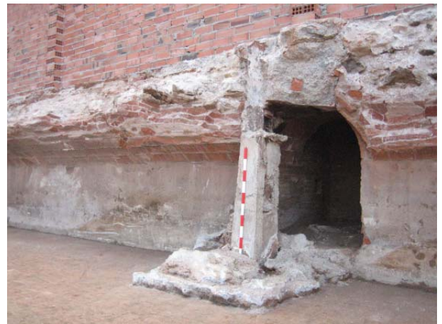
FOTO 4. Vista en detall del pou de registre UE 36, així com de la base del pilar UE 22
