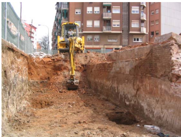
FOTO 11. Vista general dels treballs de buidatge de la part del Rec situada fora dels límits de la fàbrica
